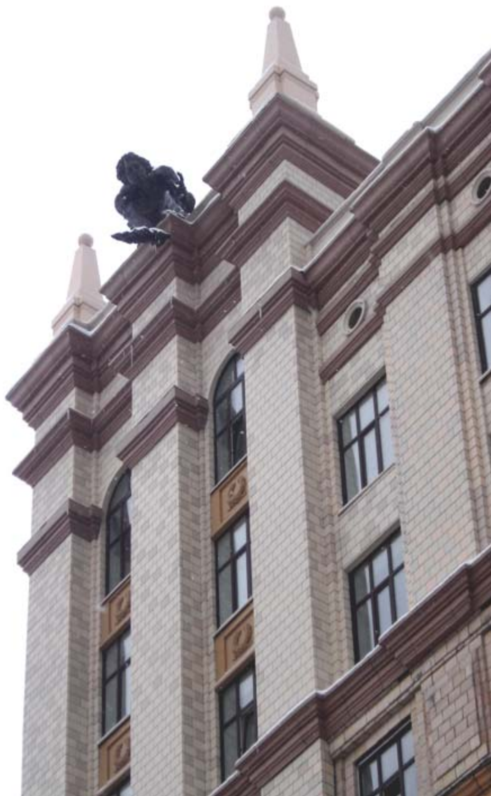
Рис.3.11. Фрагмент главного фасада центральной части университета со скульптурой Прометея. Скульптор В. А. Авакян
