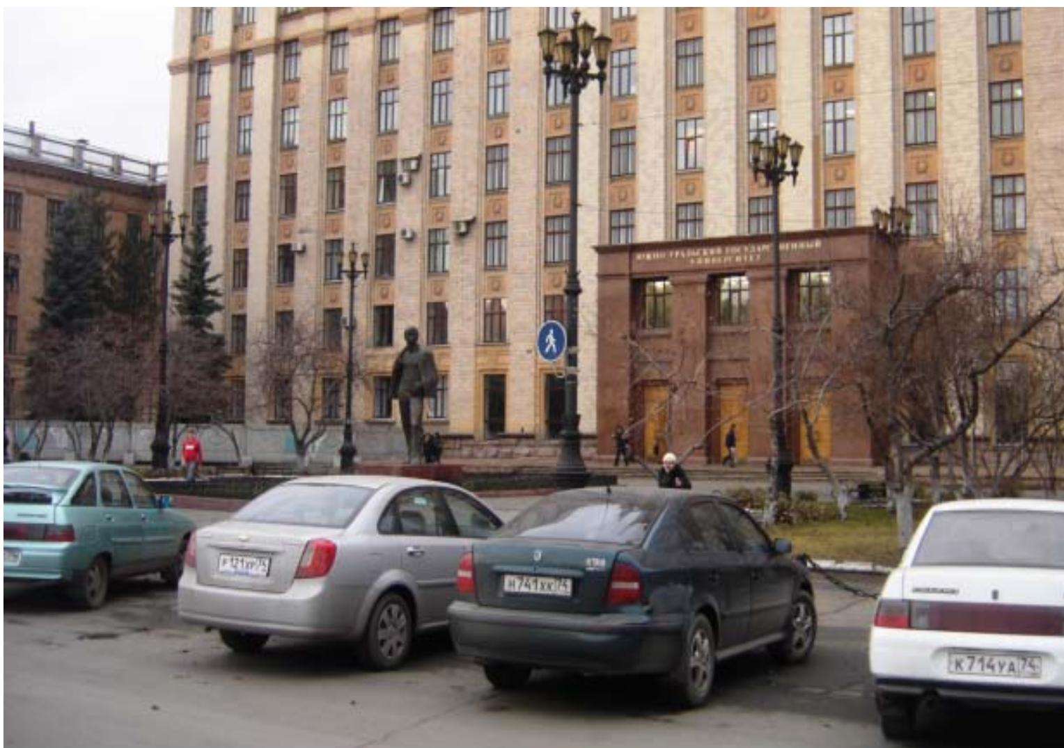
Рис. 3.13. Портал главного корпуса университета после реконструкции с выносом на четыре метра. Фото с натуры. 2006 г.
