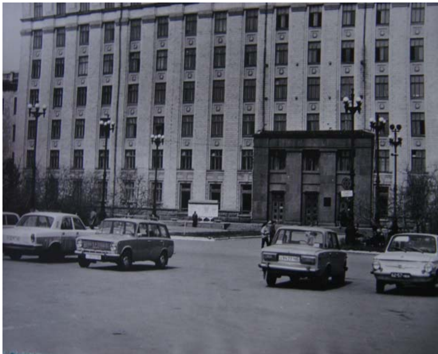
Рис. 3.12. Портал главного корпуса университета до реконструкции с выносом на 0,5 метра. Фото с натуры. 1995 г.
