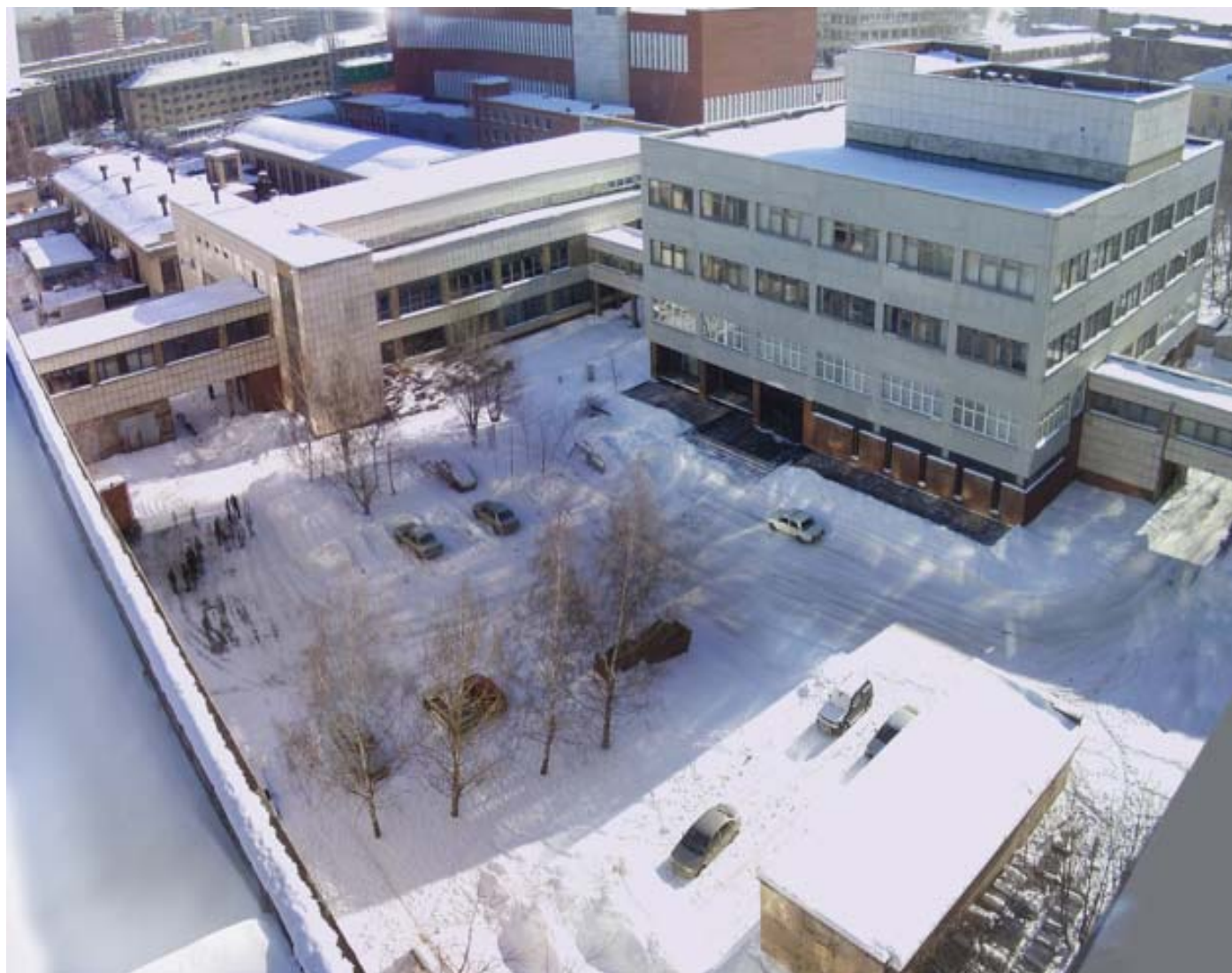
Рис. 4.18. Фрагмент двора третьего корпуса с существующим зданием научной библиотеки университета (справа). Фото с природы. 2007 г.
