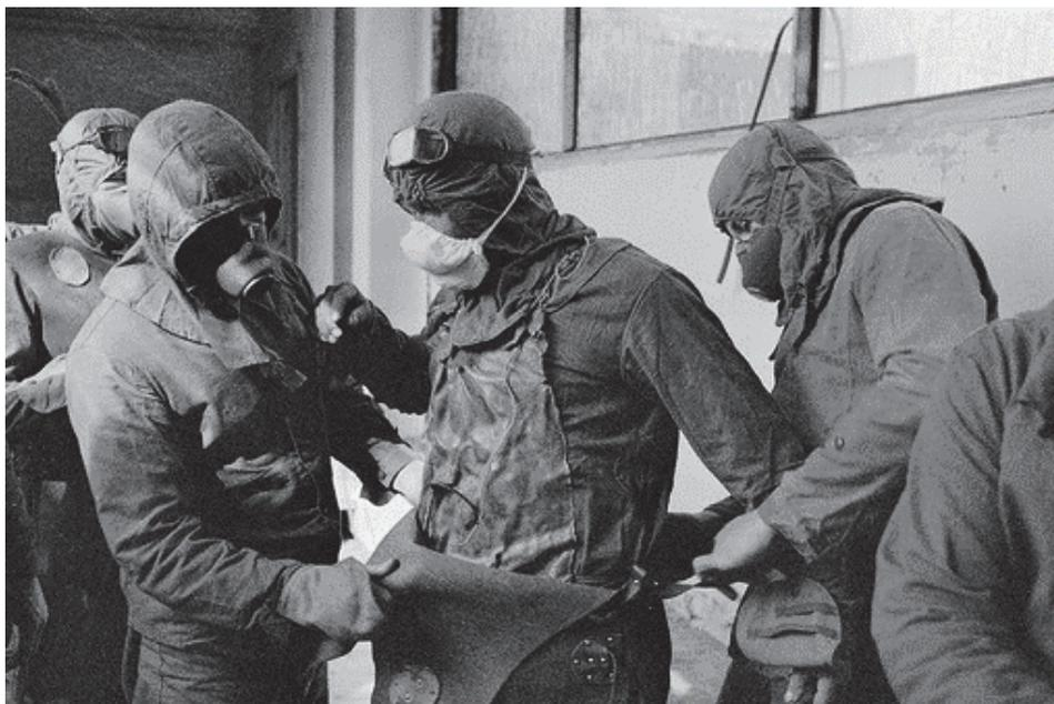
Рис. 3.7. Защитные костюмы для работы в эпицентре взрыва. Подготовка бойцов для работ по дезактивации кровли 4 энергоблока Чернобыльской АЭС
